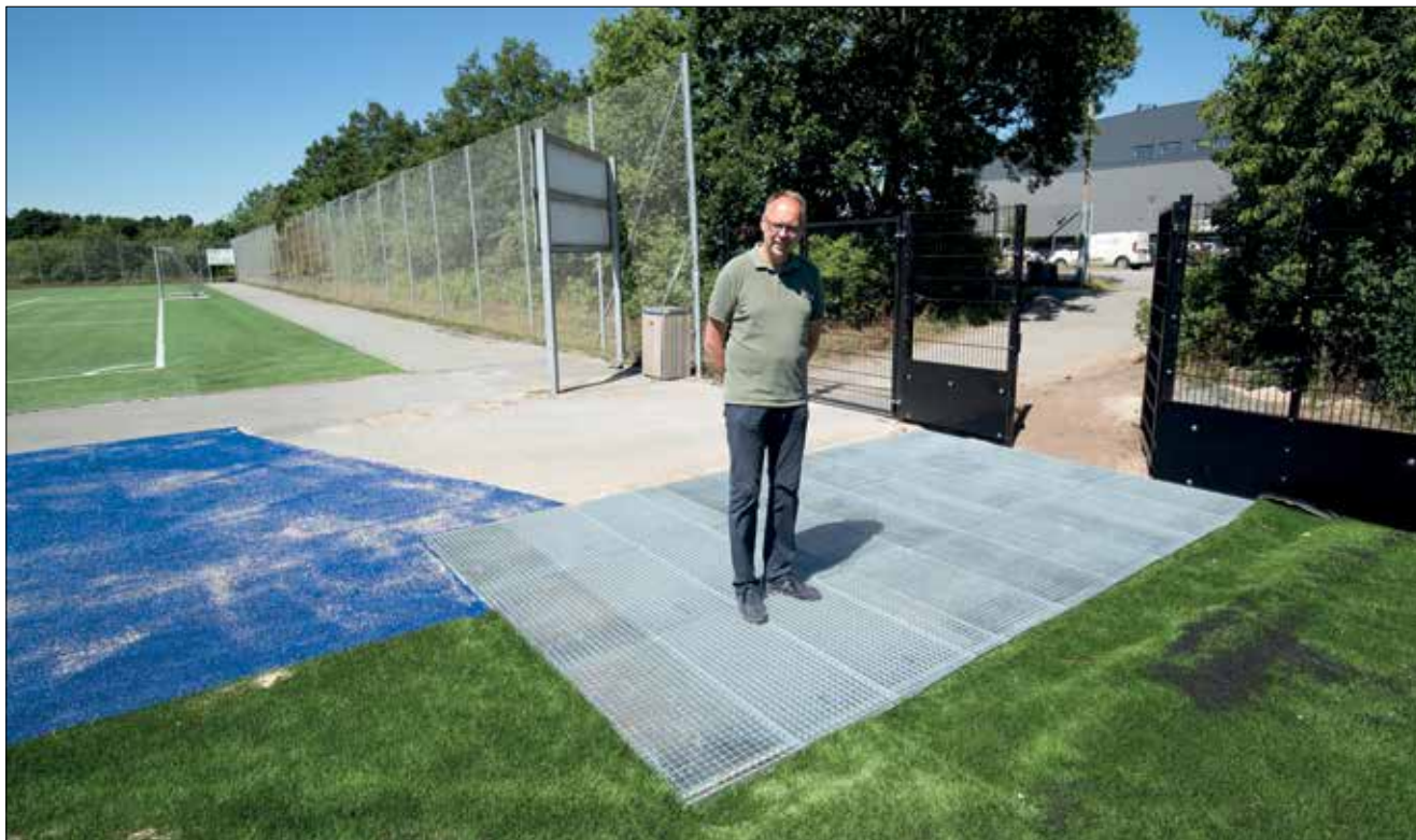
Manden på risten: Carsten Sigvert på slusen, som skal fange gummigranulat: Den overdækkes og der kommer bænke, så fodboldspillerne kan sidde og tage støvlerne af. Bag ved tv. genbrugsgræsset fra stadion, som er den grå bygning th. Det blå kunstgræs er markering af fodgængerområdet mellem fodboldbanerne. HI's blad vil følge forsøgene i Silkeborg. Du kan også følge dem hér: https://silkeborgbanen.dk . Læs også artiklen på side 9 om EU's mulige forbud mod gummigranulat.
